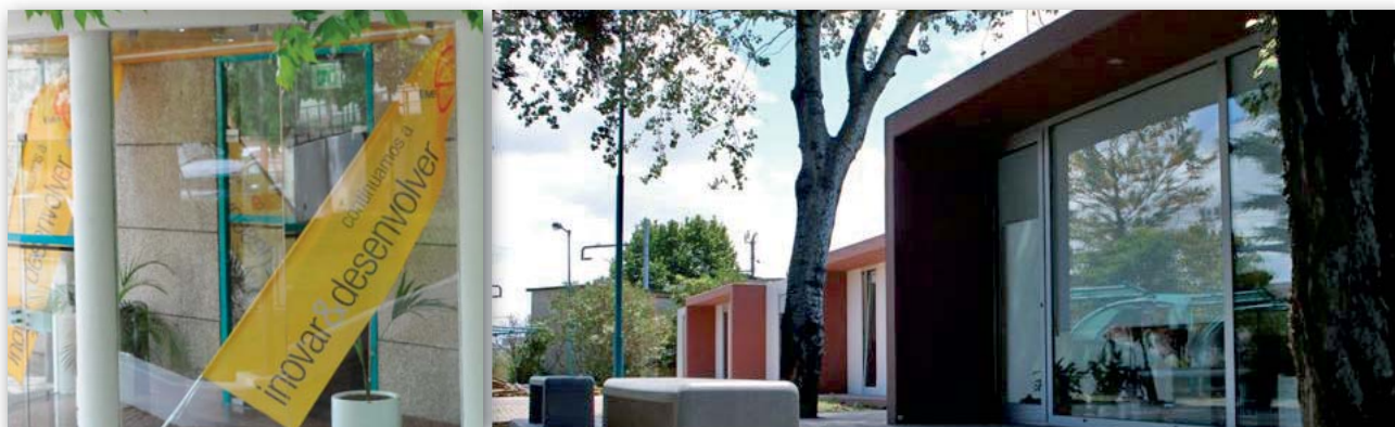
Extensão do edifício dos Serviços Centrais EMEF, colocação de módulos pré-fabricados. Edifício concluído com jardim de cobertura. EMEF Central services move in Central services expand into prefabricated cabins. Building and roof-top garden
